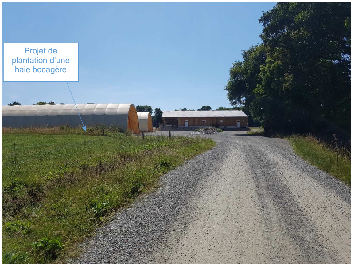
Photo n°2 : Vue côté Nord Est du chemin d'accès
