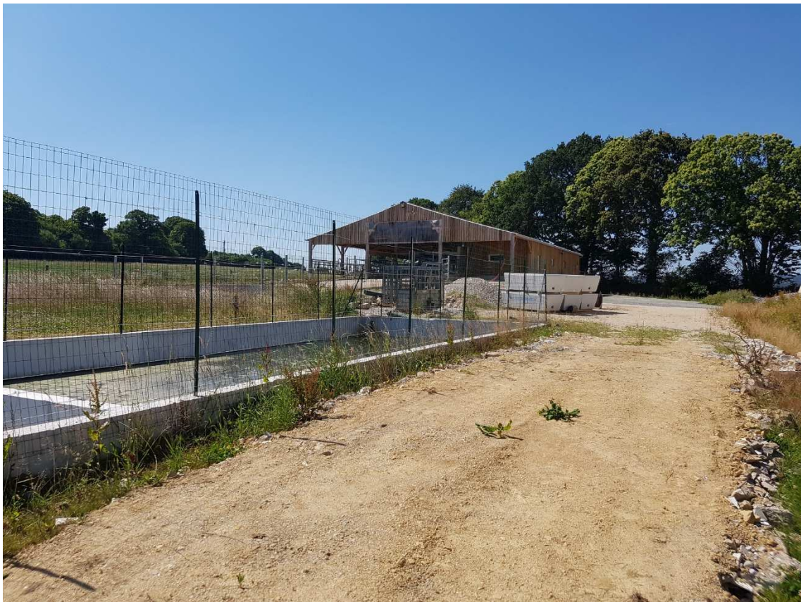
Photos n°3: Vue coté Sud du bloc de traite (bardage bois) et du BTS
